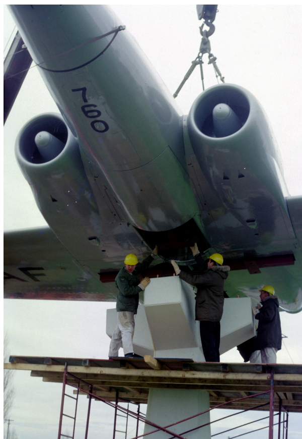
Quelques vues du transfert du CF-100 de la base militaire, où il a été préparé, vers le socle de béton destiné à le soutenir et l'installation de l'avion sur celui-ci (photos Robert St-Pierre).
