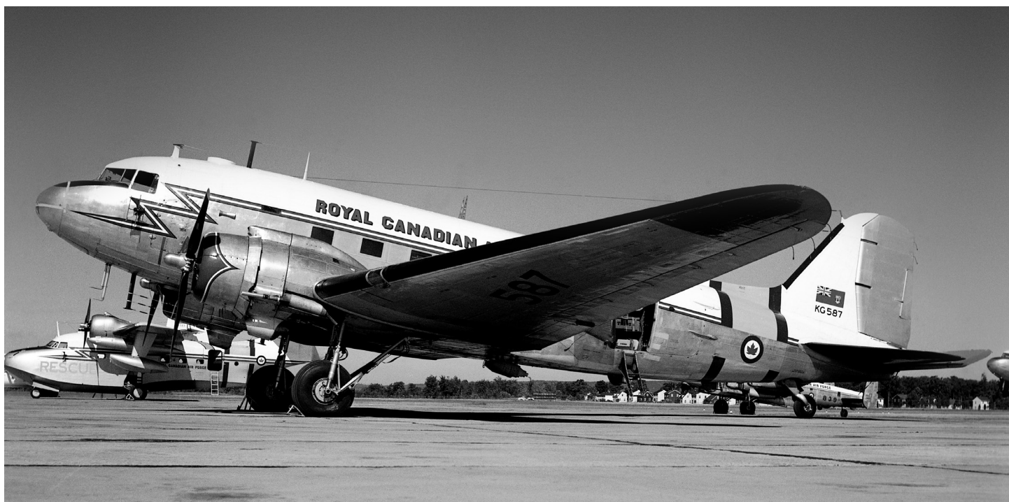
Le Douglas Dakota Mk. III KG587 vu à Trenton le 1er juillet 1961. À noter la fusée JATO installée sous le fuselage (photo Larry Milberry).
