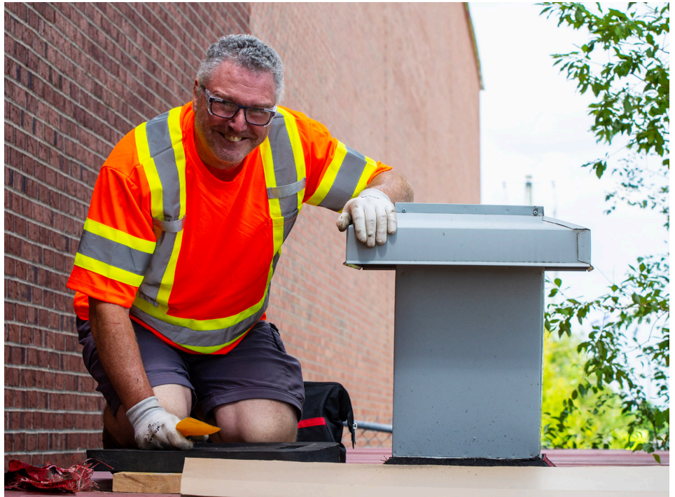
Notre membre et coordonnateur du projet Mortensen, Stéphane Drolet, procédant à une réparation sur la cheminée d'aération sur le toit du conteneur (photo Pierre Gillard).
