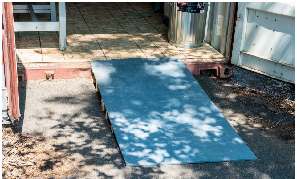
Une rampe amovible facilitant l'accès au conteneur a été la première amélioration apportée (photo Pierre Gillard).
