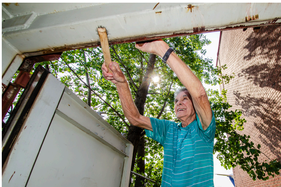
Édouard Painchaud s'attaque à la rouille située sur le pourtour des portes du conteneur (photo Pierre Gillard).
